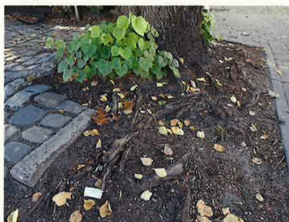
Afb.5: Schade oppervlakkige beworteling boom 8
