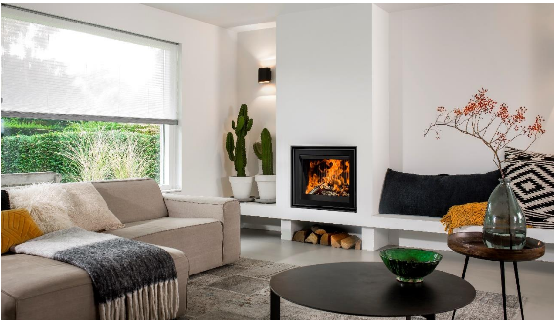
Figuur 2.3 Voorbeeld van een inbouwhaard waarbij de schouw later om het toestel is gebouwd (Barbas)
