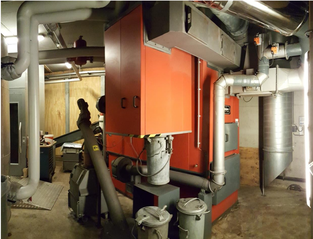
Figuur 2.10 Een houtsnippergestookte ketel van 400 kW ter verwarming van een overdekt zwembad (Binder)
