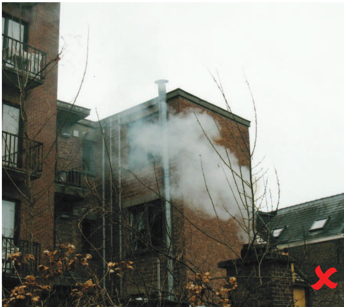
goede praktijk plaatsing rookgasafvoerkanalen
