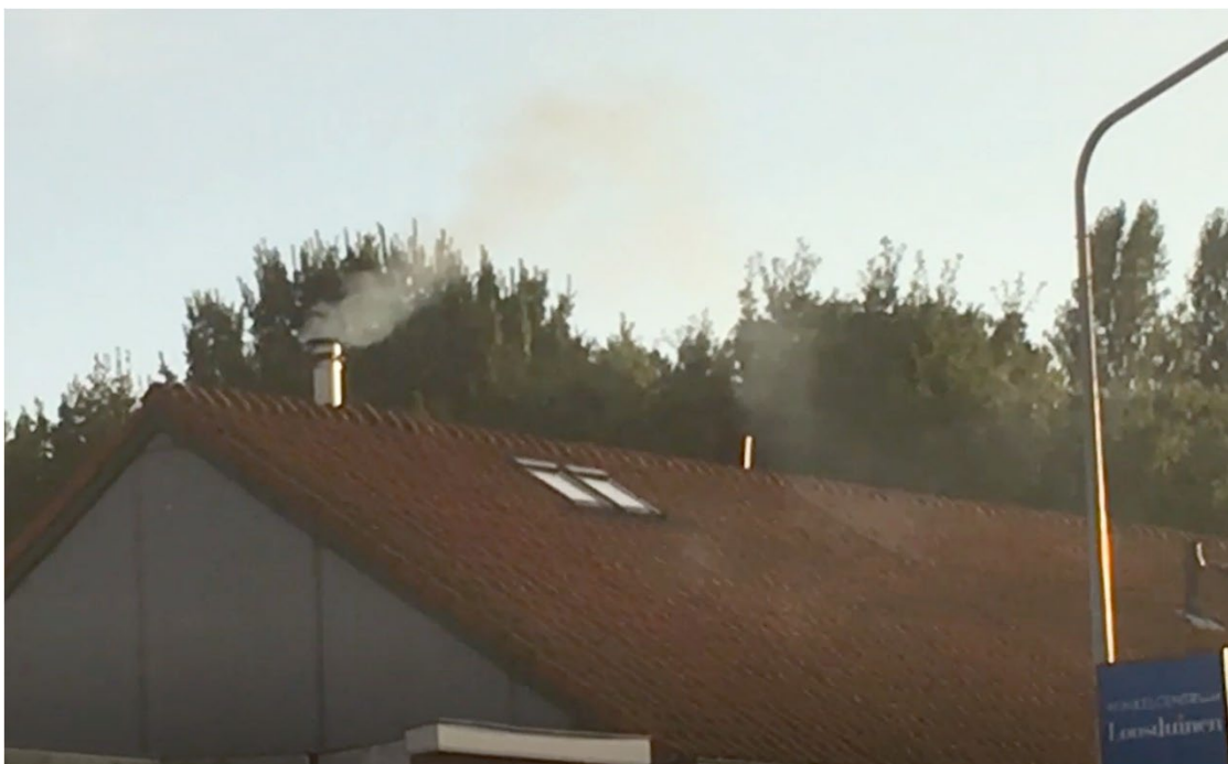
Afbeelding 8.15: Lijwerveffect waardoor de rookpluim omlaag wordt gezogen.
