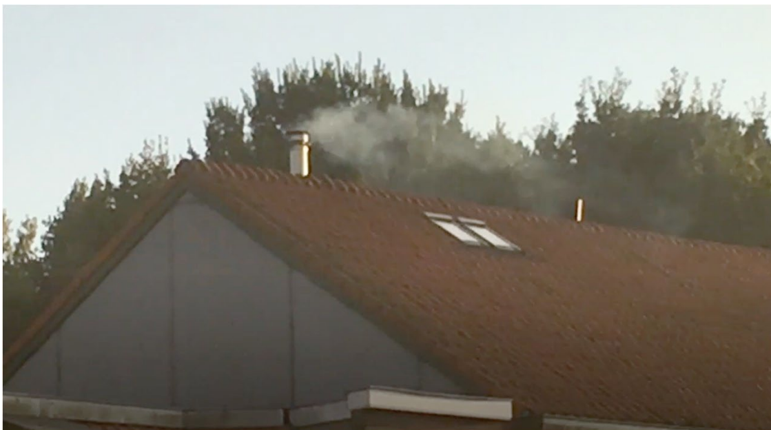
Afbeelding 8.14: Pluimasverlaging bij afvoer boven nokhoogte.
