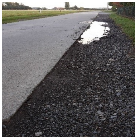
Fig. 88: Berm uitgevoerd in kiezels
