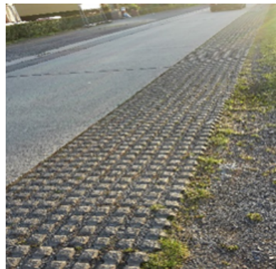
Fig. 85: Gevaarlijke afscheiding tussen weg en berm
