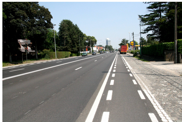
Fig. 82: Fietspad naast drukke snelweg
