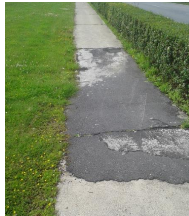
Fig. 91: "Opgelapte stroken in het wegdek
