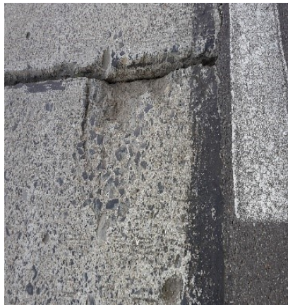
Fig. 90: putten in het wegdek
